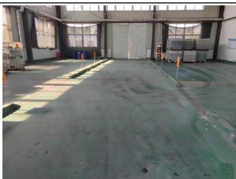
危废库-导流槽
